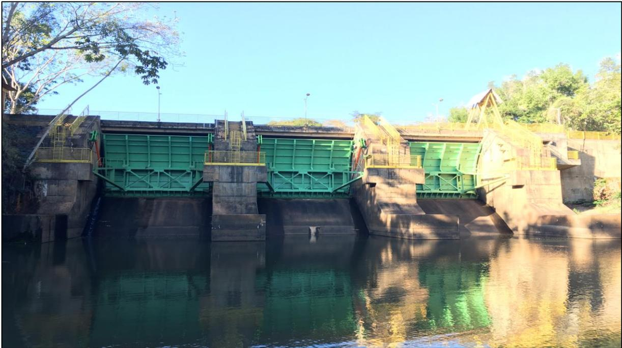
**Figura 5.3 - Vista a jusante dos vãos do vertedor da barragem da PCH Glória.**
