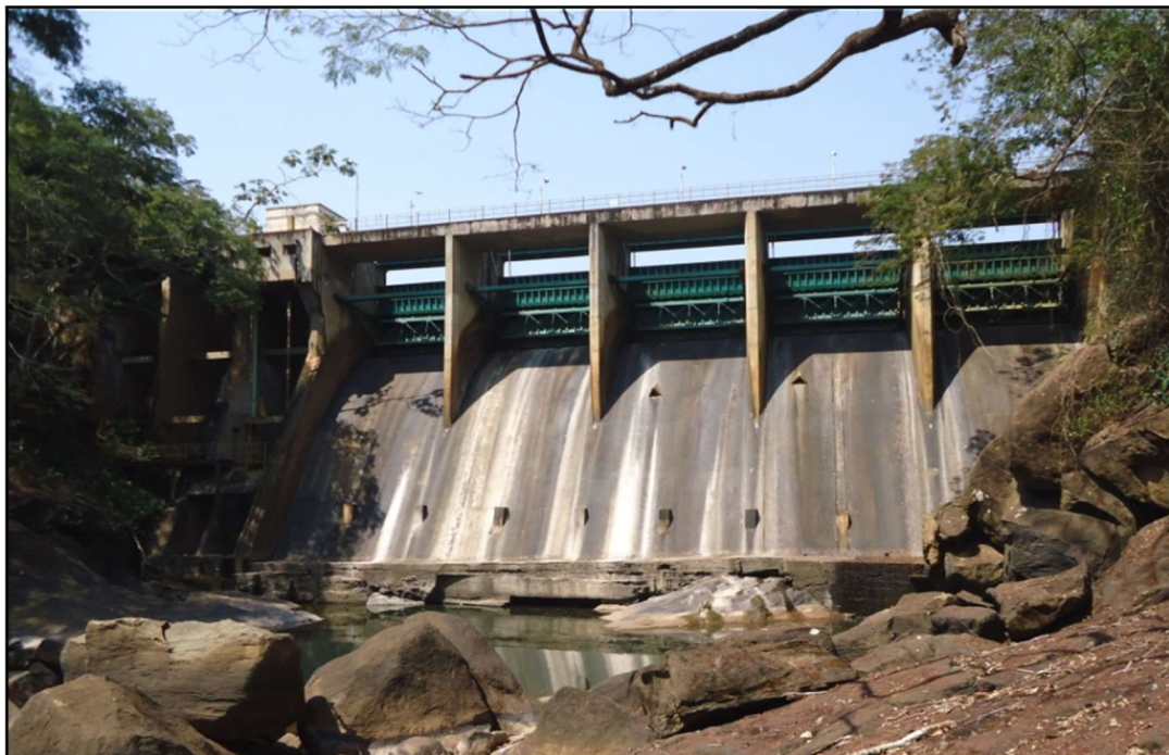
Figura 5.1 – Vista a jusante dos vãos do vertedor da barragem da PCH Nova Maurício.
